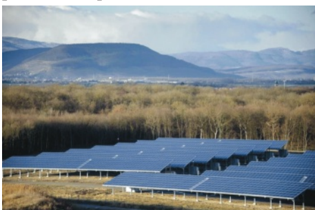
40 000 m 2 de panneaux photovoltaïques
